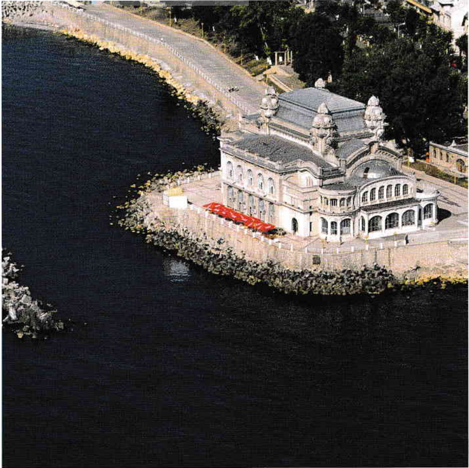
Vedere aeriană a falezii oraşului Constanţa, dominată de clădirea elegantă a Cazinoului Aerial view of the Constanţa seafront, dominated by the elegant Casino
